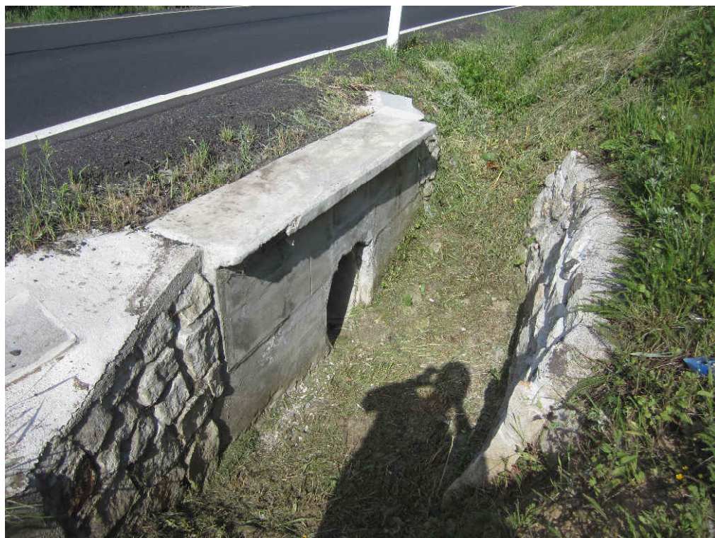
vtok trubiňho propustku DN 600 v km 6,442
