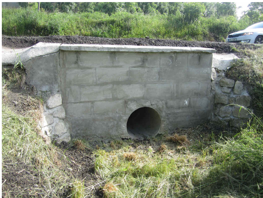
výtok trubiňho propustku DN 600 v km 6,442
